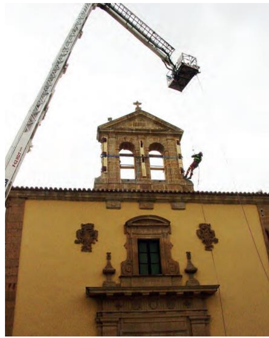
F12 : Exercice en hauteur, protection d'un beffroi, Salamanca, 2017. © UGRECYL
