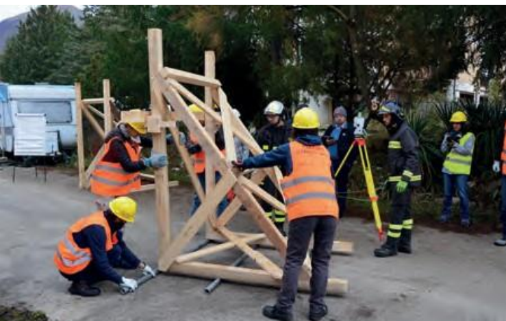
3 Participants mettant en place une structure d'étaie dans un scénario de patrimoine culturel pendant le cours FAC de l'ICCROM, 2019, qui s'est tenu à Rome et à Norcia (Italie).
