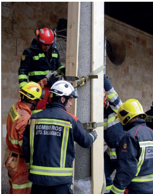
F11 : Renforcement de colonne, Salamanca, 2017. © UGRECYL
